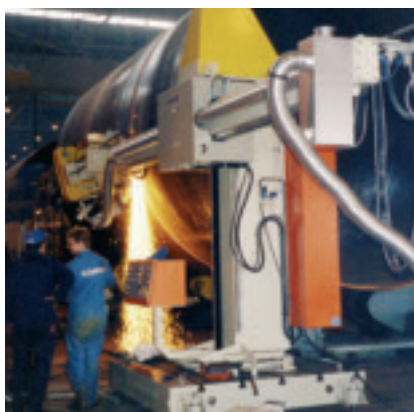
Vorbereitung der Schweißnahtwurzeln
